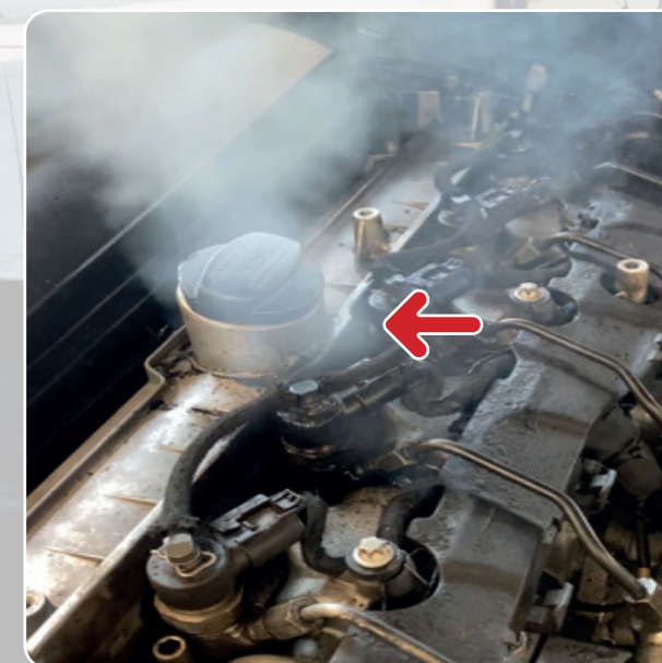
EMISIONES CONTAMINANTES Condiciones inadecuadas por fuga en inyector
